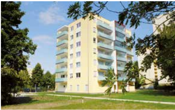
Neubau an der Landsberger Allee
