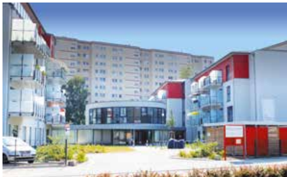
Neubau an der Platte Schleusinger Straße
